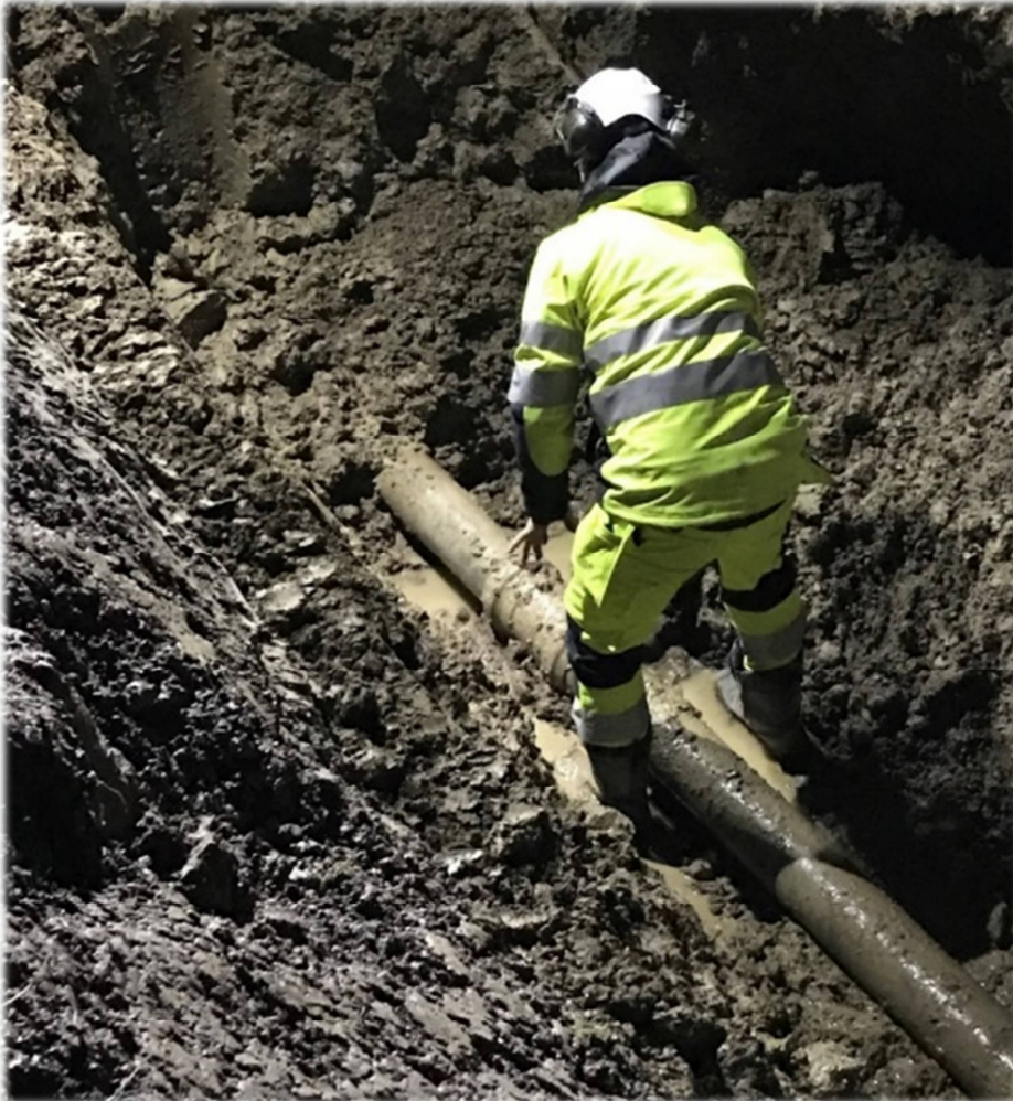
Figur 5 Ledningsarbete med kommunal VA-ledning
