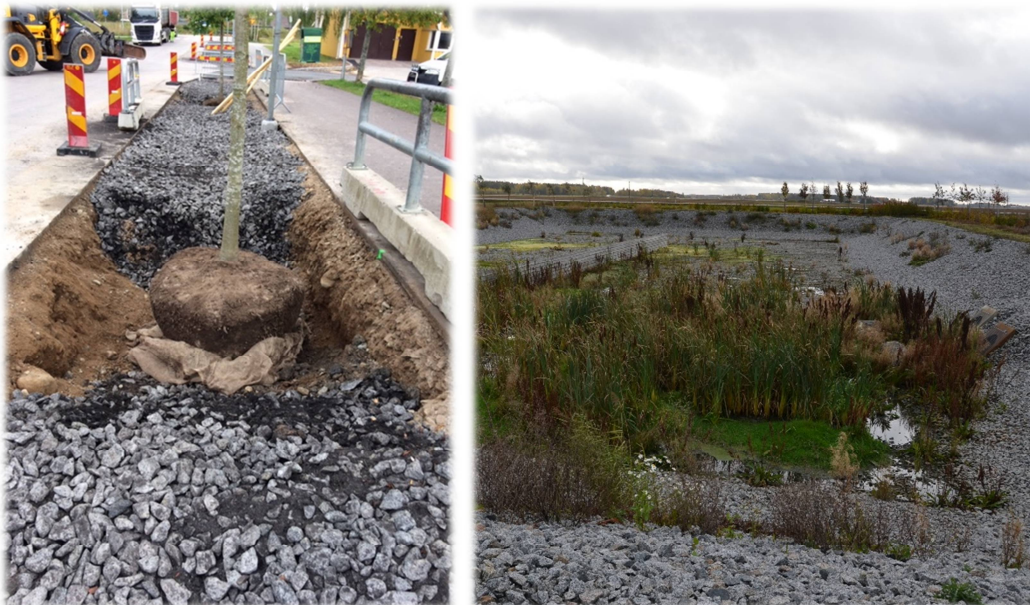
Figur 6 Dagvattenlösning vid Måns Ols och Fridhem
